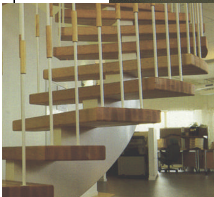
Svängd trappa i lönn och vitlackerat, med ett underliggande vangstycke.
