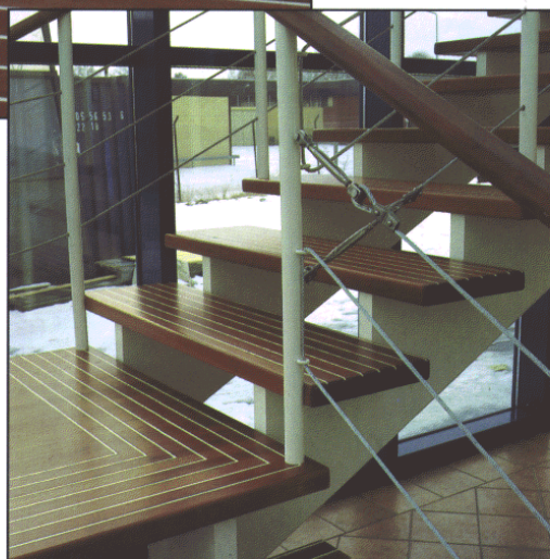
Trappa med två under- liggande vangstycken. Steg i mahogny—nåtade.
